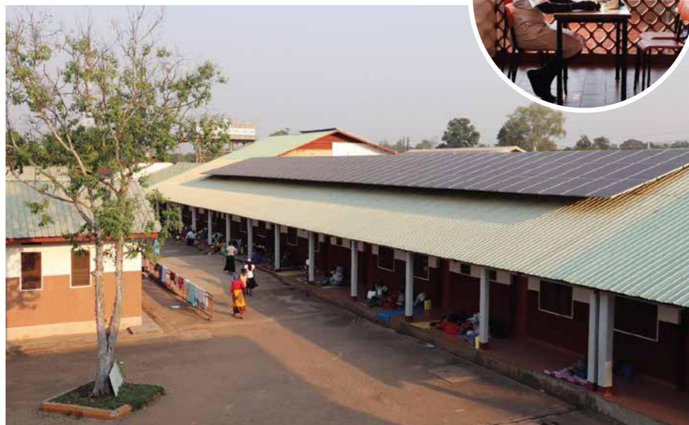
Scorci degli impianti ad energia solare installati nell'ospedale
