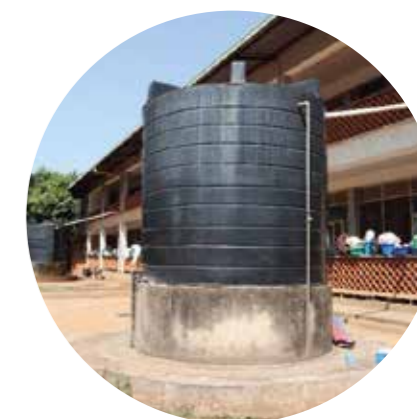
I serbatoi in plastica nera raccolgono l'acqua piovana dai tetti e la forniscono direttamente ai familiari dei pazienti tramite appositi rubinetti.
