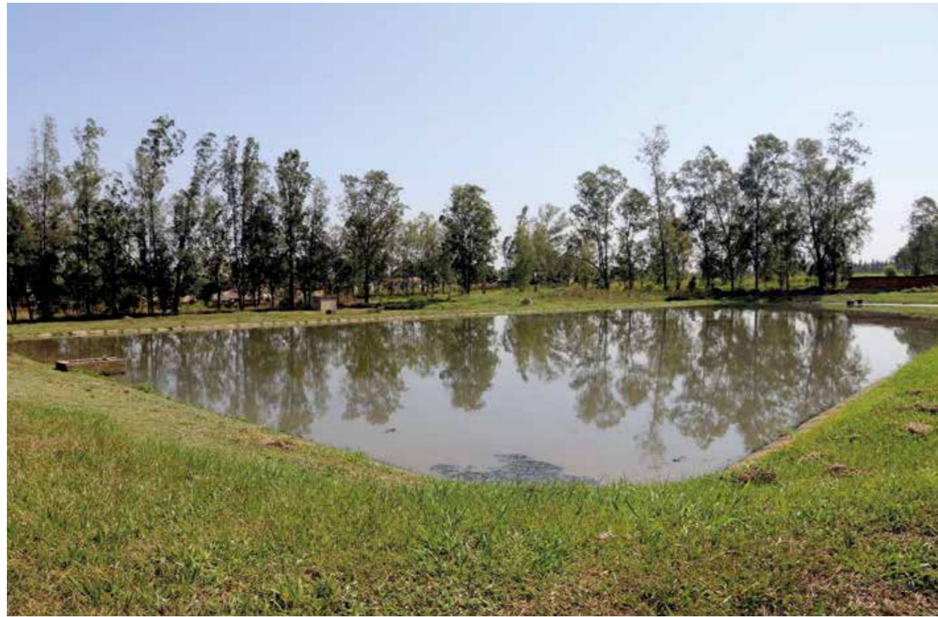
Una delle vasche di decantazione dell'acqua fognaria, situata fuori dal recinto dell'ospedale
